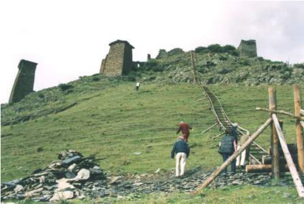
De “Keselo-express” voor het transport van bouwmaterialen naar de torens
