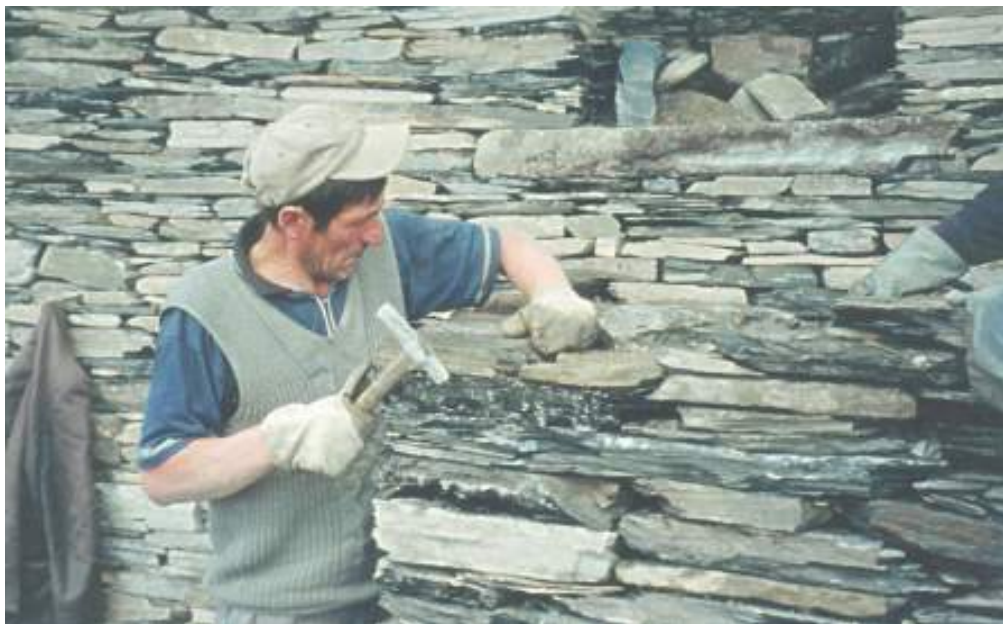
Zonder metselwerk en slechts met gebruikmaking van een hamer en handschoenen wordt de toren weer opgebouwd
